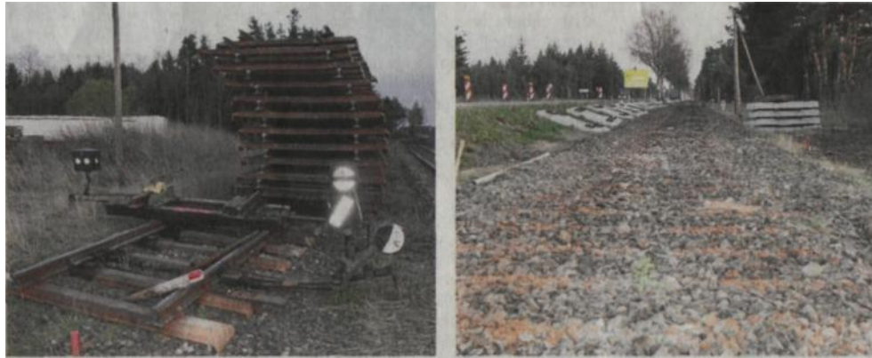
Die alten Gleise sind abgebaut, das neue Schotterbett ist aufgeschüttet: Komplett erneuert werden die Gleisanlagen zwischen Schongau und Landsberg
