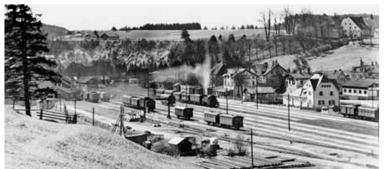
Blick auf den Bahnhof Schongau in den 1930er-Jahren mit abfahrtsfertigem Dampfzug in Richtung Landsberg.
